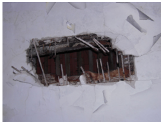
Slika 80: dvorana nad slavnostno dvorano, druga nadstropje Slika 81: poškodbe v stropu, druga nadstropje
