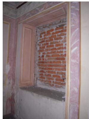
Slika 79: zazidano okno v kapeli
