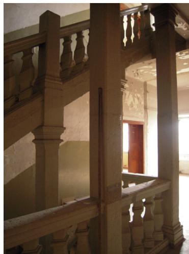
Slika 9: stopnišče z balustrado
