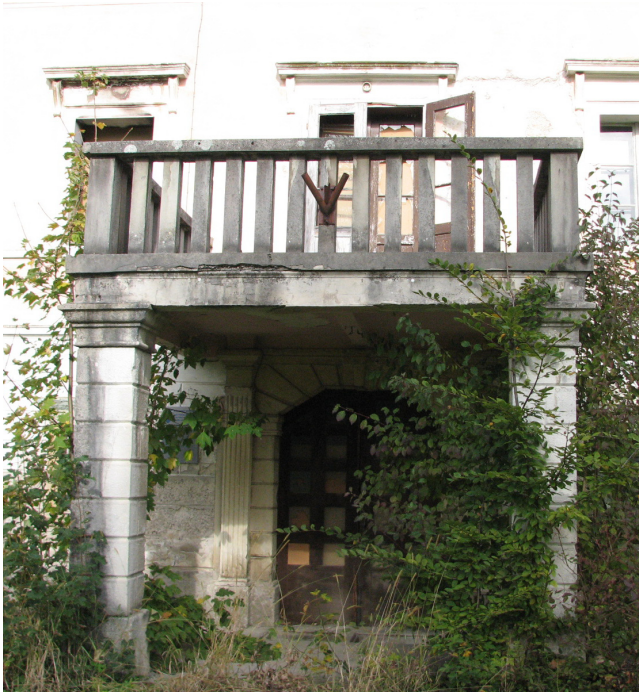
7.1.2.4 Stebra ob glavnem portalu na južni fasadi, ki nosita balkon (2 kom)
